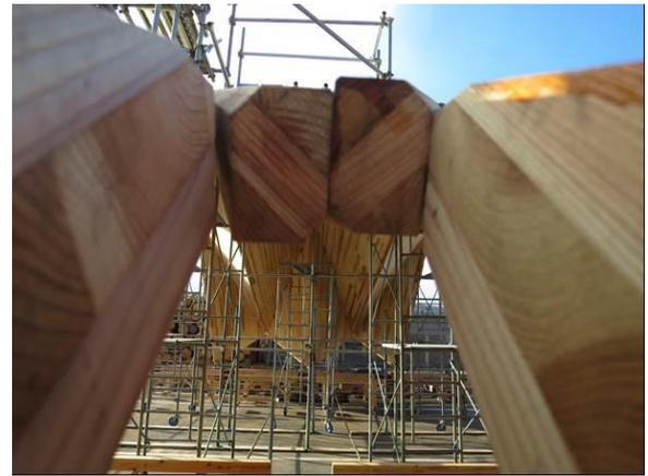
写真 4.10.12 隣接する CLT 間の状況
