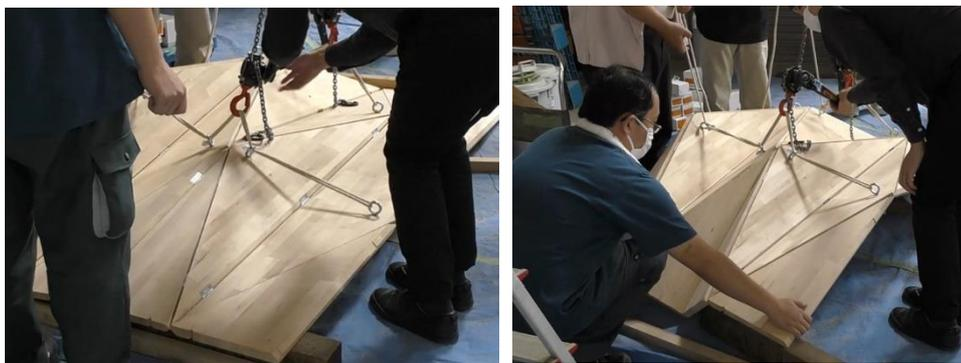
写真 3.2 モデル 2 のパネル組み立て風景
