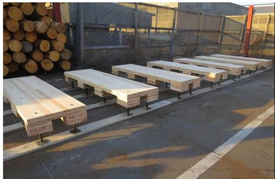
写真 4.3.5 CLT 基盤設置
