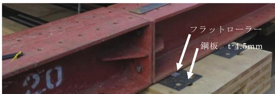
写真 4.3.9 山留用鋼材の設置状況
