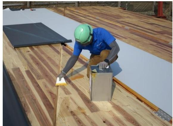
写真 4.8.16 防水の施工
