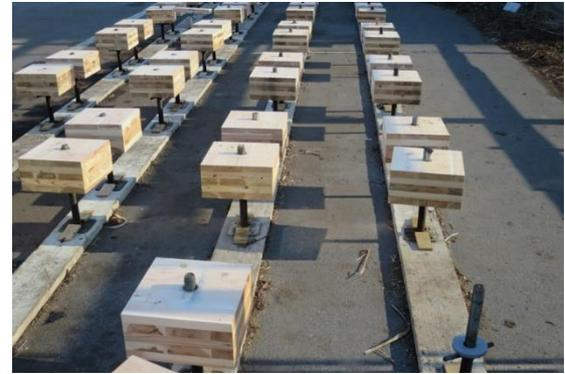
写真 4.3.4 CLT のスパースー取り付け
