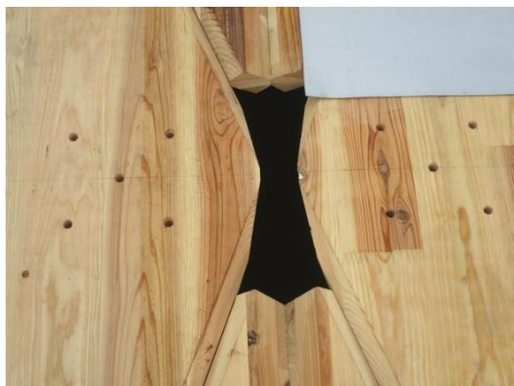
写真 4.10.14 頂部の CLT 加工
