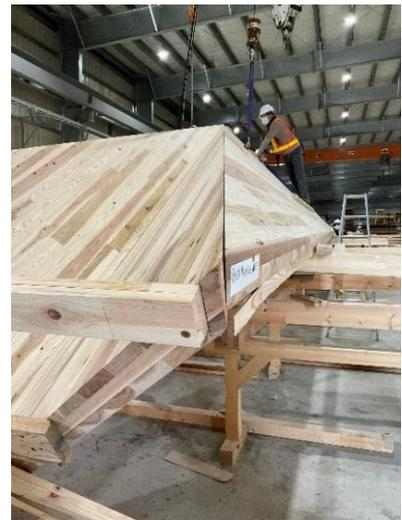
写真 2.2.3 CLT-CLT の取り合い部
