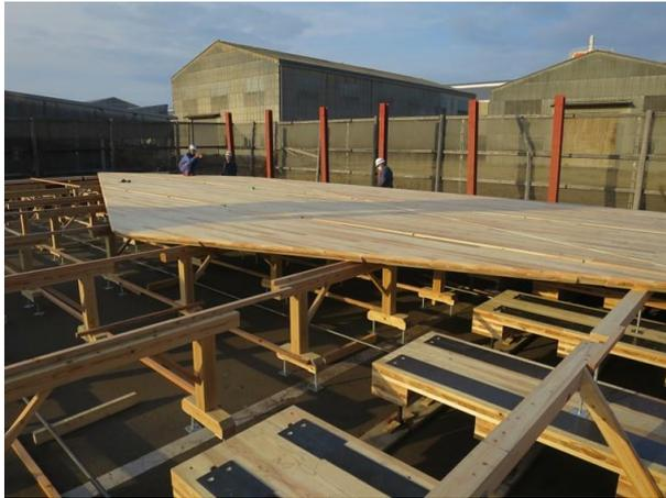
写真 4.8.7 CLT の敷設風景
