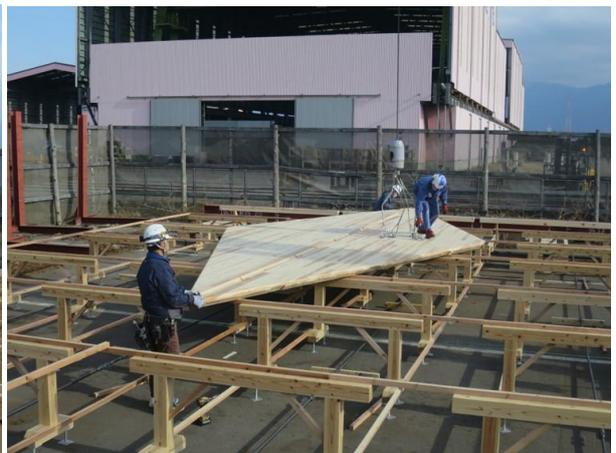
写真 4.8.4 CLT の敷設風景
