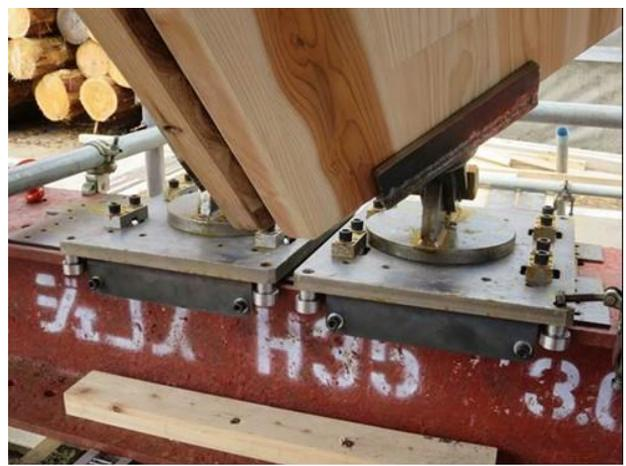
写真 4.4.4 支承金物と CLT の接合 (下面)
