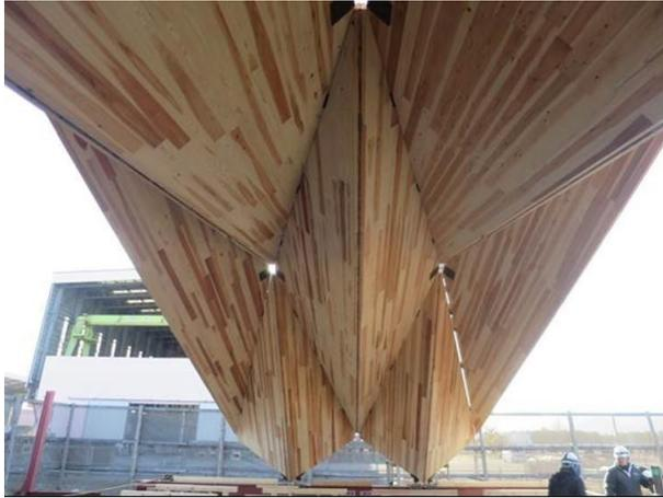
写真 4.10.7 CLT-CLT 間の隙間状況
