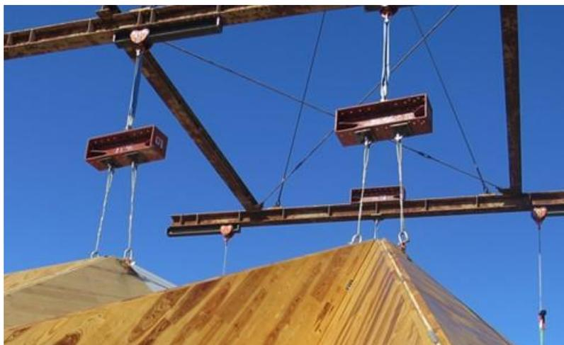
写真 4.10.13 CLT 頂部の吊り方の状況
