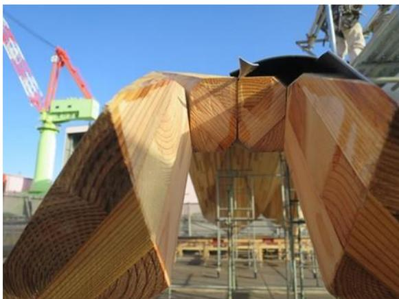
写真 4.10.11 隣接する CLT 間の状況
