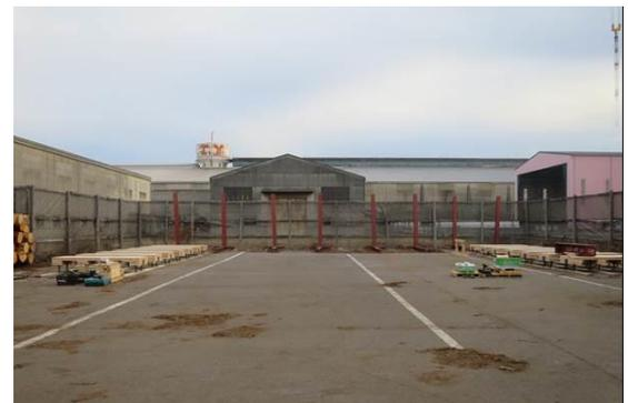
写真 4.3.6 仮設基礎設置状況
