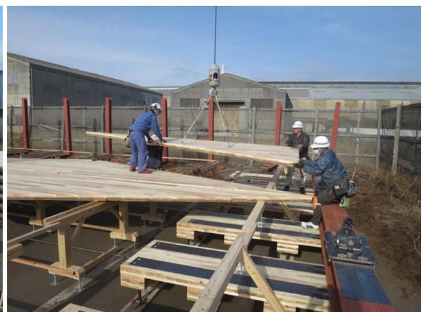
写真 4.8.6 CLT の敷設風景
