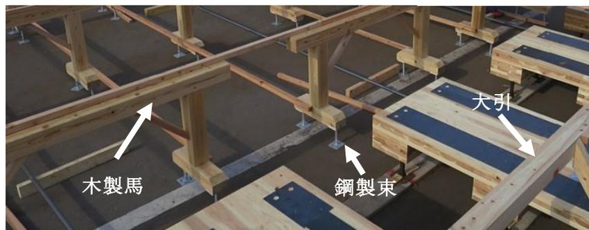
写真 4.3.8 木製馬および大引きの設置状況
