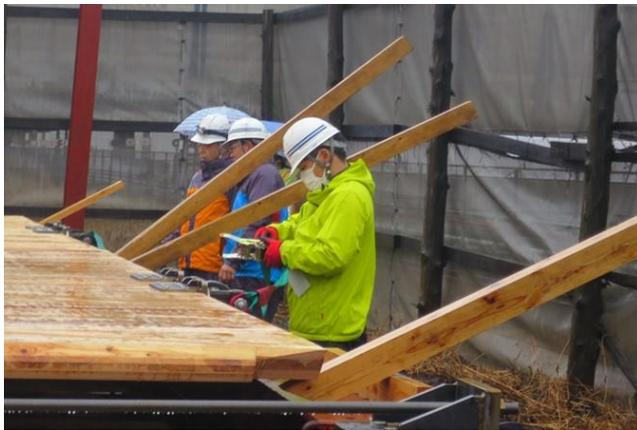
写真 4.10.2 角材による、てこの原理
