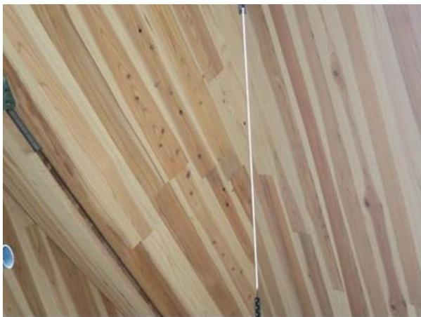
写真 4.10.9 CLT-CLT 間の隙間状況
