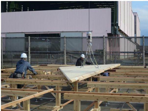
写真 4.8.3 CLT の敷設開始
