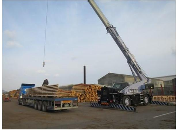
写真 4.8.2 CLT の荷下ろし
