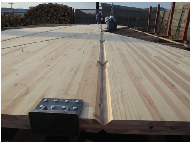
写真 4.8.9 CLT の敷設風景
