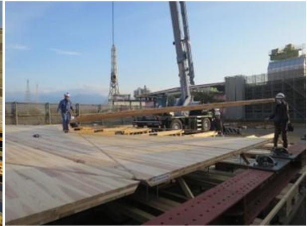
写真 4.8.8 CLT の敷設風景
