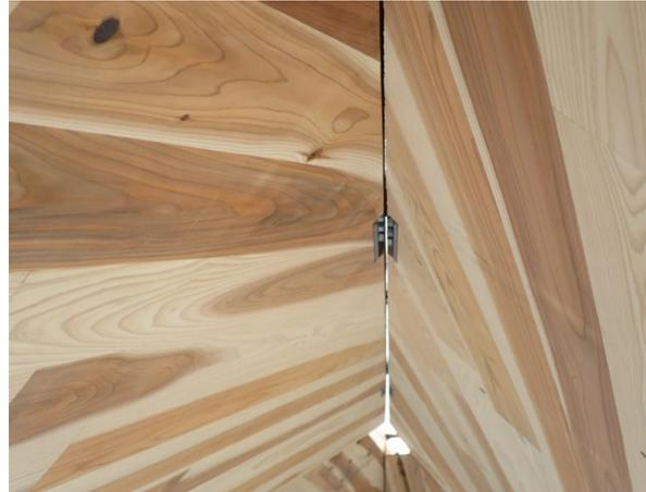
写真 4.10.8 CLT-CLT 間の隙間状況
