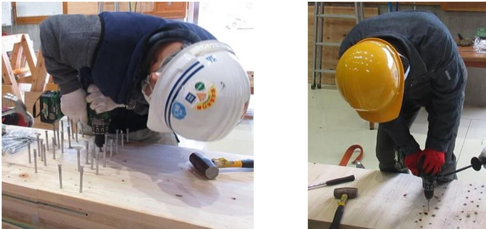
写真 2.1 鋼板挿入式木ビスの打ち込み状況
