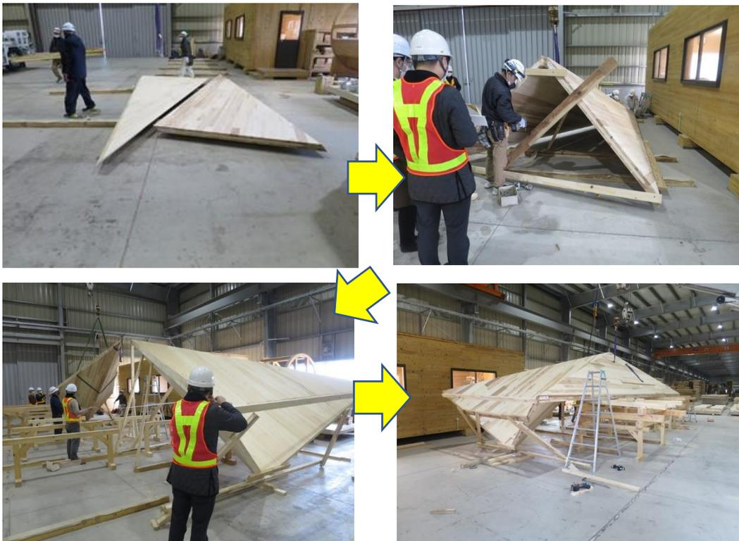
写真 9.1 折版構造の CLT の加工・組み立て
