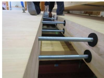
写真 7.5 鋼材挿入
