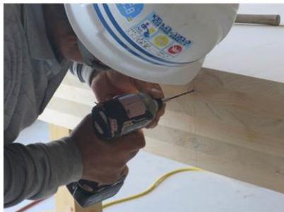
写真 7.1 よび穴加工
