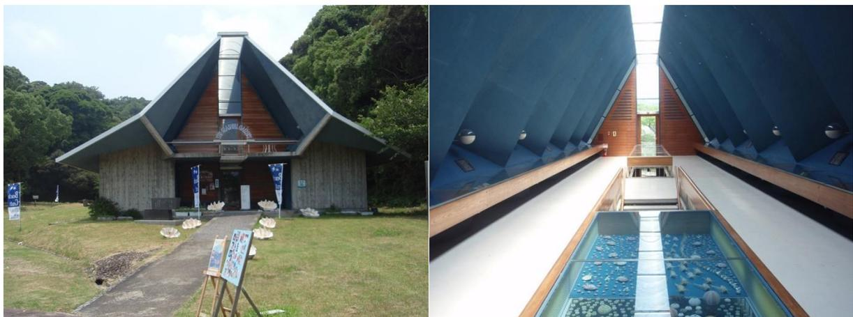
写真 1.1 折版構造による屋根の事例（鉄筋コンクリート造）
