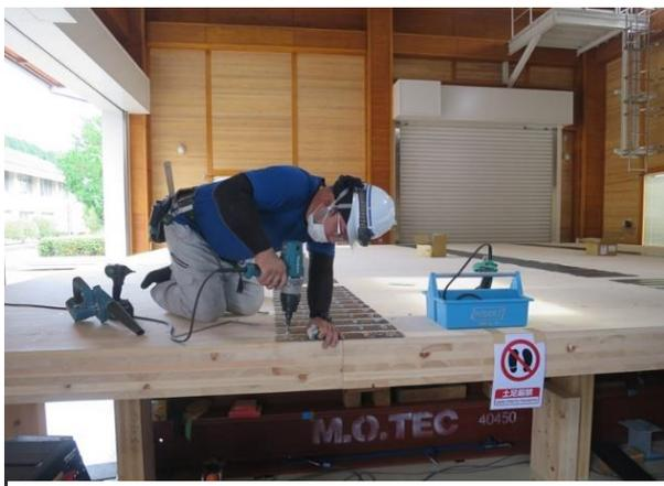
写真 7.11 接合具打ち込み（上面）
