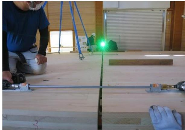
写真 7.10 CLT 引き付け
