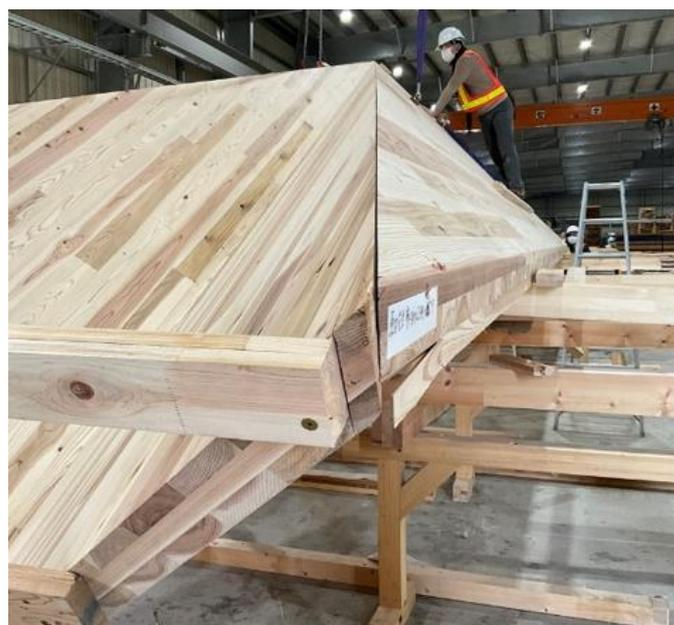
写真 8.10 CLT 平板上の角材による足掛かり
