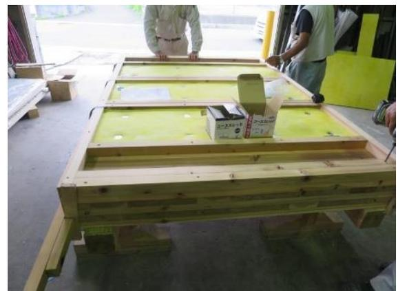
写真 6.2-3-4 断熱材取り付け
