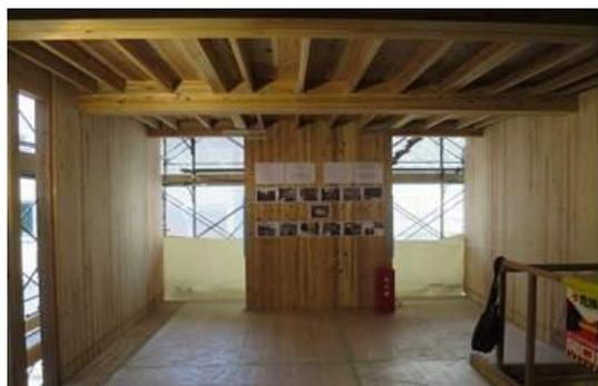
写真 5.2-1 CLT パネル工法 工事風景 (事務所ビル)
