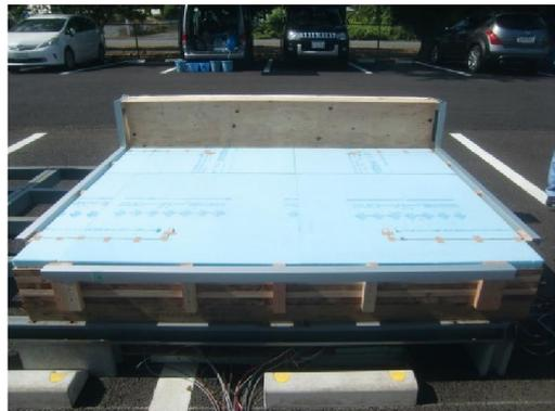
写真 8.2.3-4 通気溝付勾配断熱材敷設
