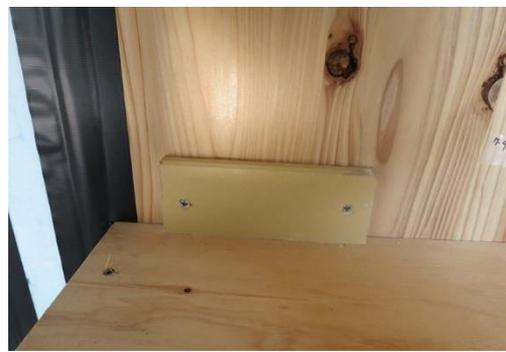
写真 7.5-5 接合金物の石膏ボードによる被覆
