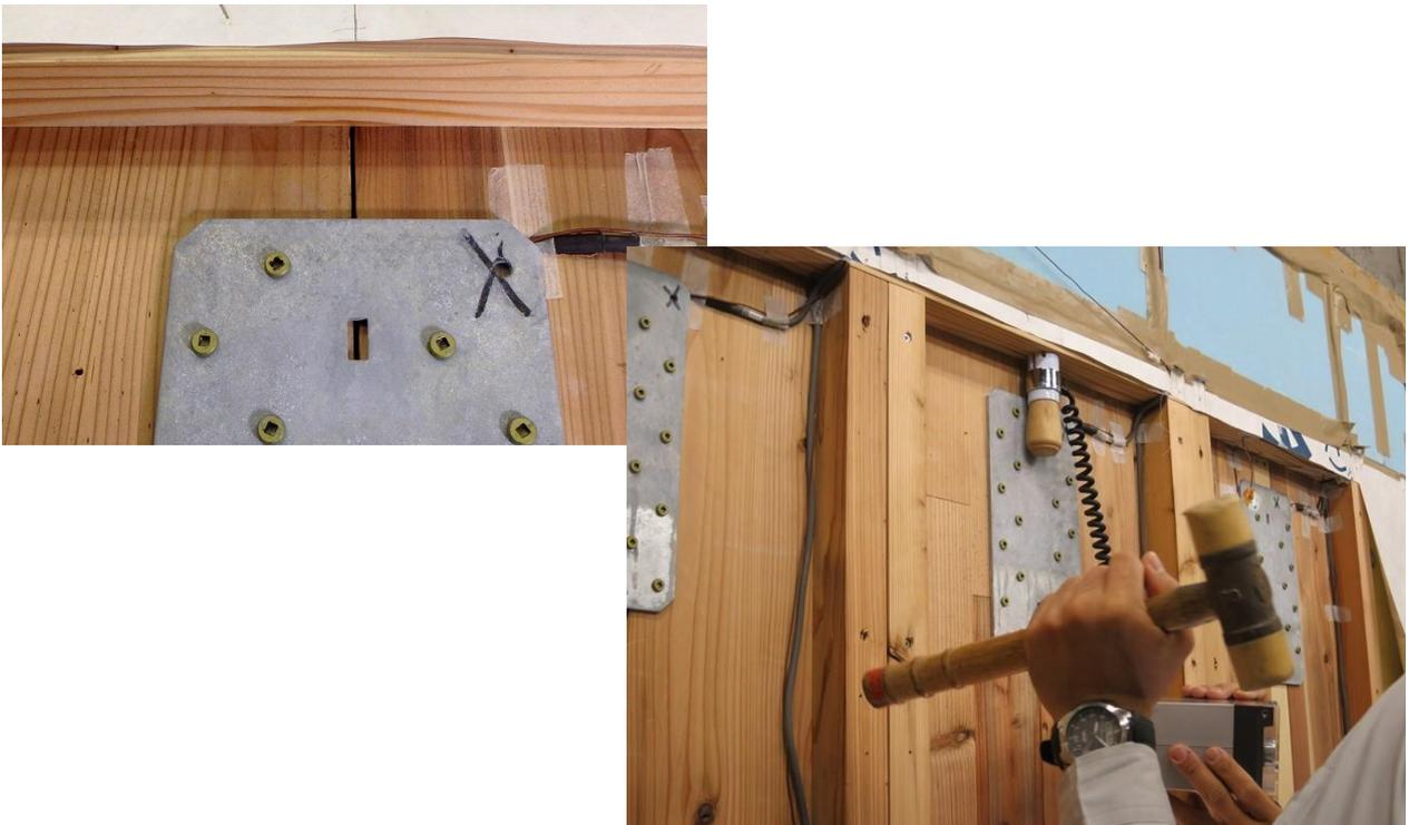
写真 6.4-14 結露観察状況（目地 B CLT 室外側）
