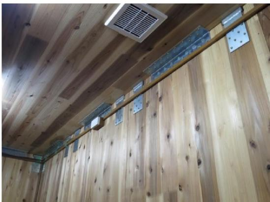
写真 9.2-3 CLT パネル工法に使われている接合金物の事例
