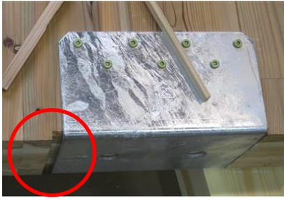
写真 7.5-1 CLT を跨ぐ接合金物
