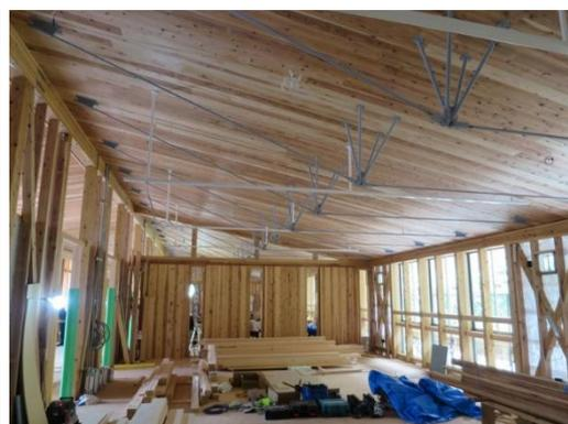
写真 9.2-2 CLT と鋼棒で張弦梁を構成した屋根の事例
