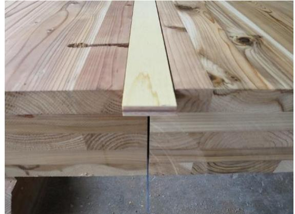
写真 6.2-2 CLT 隙間部への
