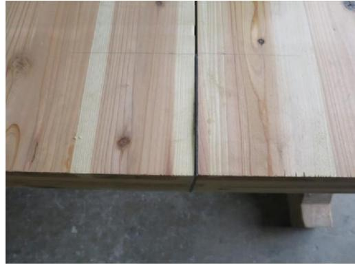
写真 5.2-3 CLT 間の目地幅調整
