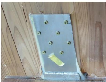
写真 9.2-5 接合金物と CLT 間の隙間処理
