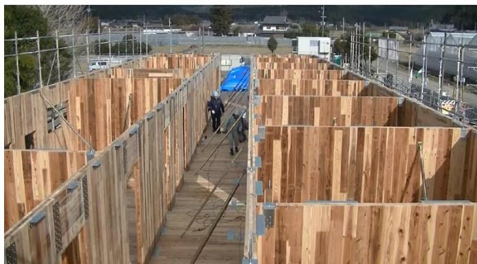
写真 9.2-1 CLT パネル工法の壁の建方
