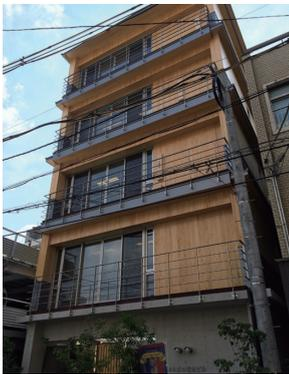
木造の耐火構造は、被覆型、鉄骨内蔵型、燃え止まり型の3手法が実用化されています(表)。現在、すべての主要構造部について1時間耐火構造の部材が開発されていますので、最上階から数えて4層までを木造でつくることができます(注)。さらに、最近では被覆型による2時間耐
