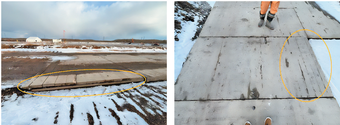
写真-9 苫小牧の造成地に設置されたCLT敷板
