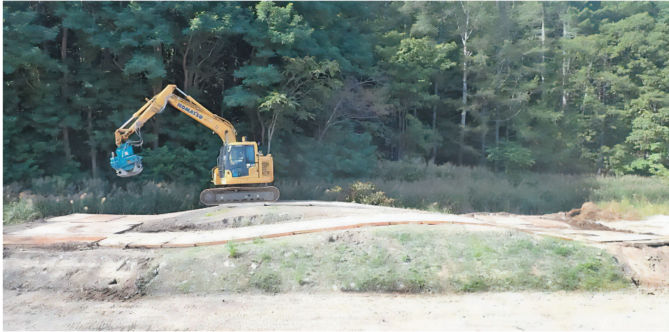
写真-8 疲労試験（繰り返し走行試験）の様子
