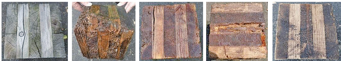
GL+0.5m 木部亀裂、幅はぎ隙間が職職に変色 GL+0m 接地部分で腐朽・蟻害 GL-0.1m 木部の腐朽・蟻害・亀裂 GL-0.5m 木部腐朽、蟻害 GL-1.5m 接着層近傍の微小亀裂
