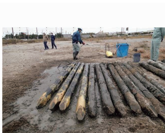
写真2 木更津市における杭丸太の掘出し
