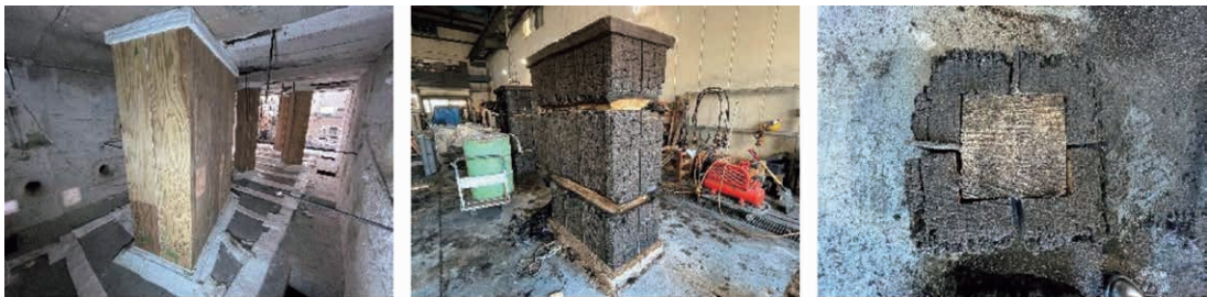
写真4 耐火試験前後
