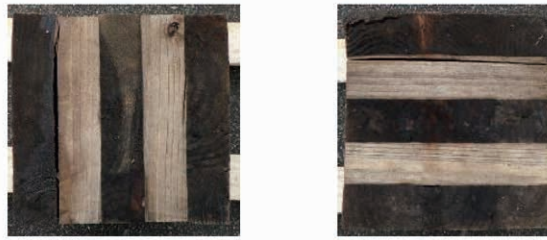
写真-12 劣化状況の例（土壌中・旭川）
