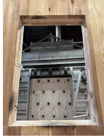
写真-14 解体時の開口小口の例 (試験体②仕様 1/CLT炭化なし)
