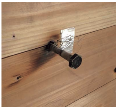
写真-19 解体時の留め具の例 (試験体③仕様 1/ 抜ける)
