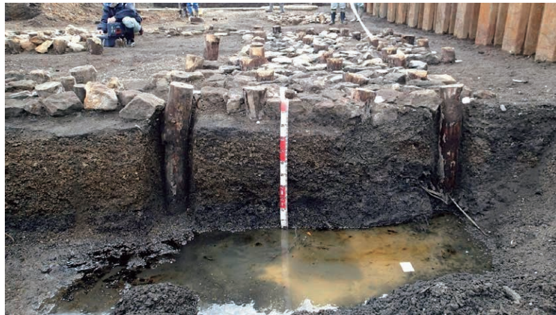
写真3 墨田区横川における杭丸太の状況
