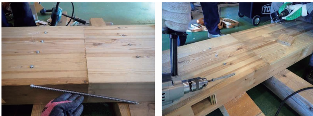
▲ 引きボルト式継手と斜めビス打ちを併用した高耐力継手の組立
