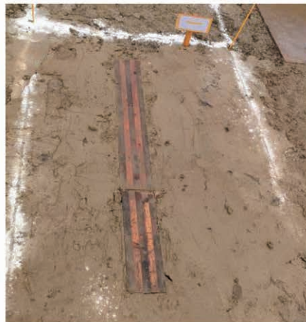
(a) セメント固化材使用 (パターン②)
