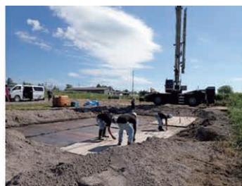
(b) CLTの吊り上げ状況
