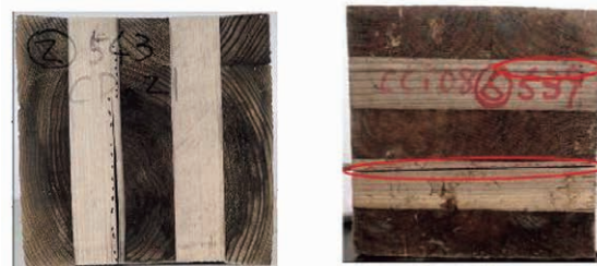
写真-16 劣化状況の例（淡水中・野田）
