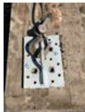
写真-20 吊上金物
