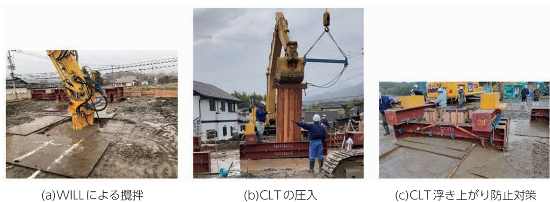
写真-8 CLT鉛直地盤補強の実施工実施状況
