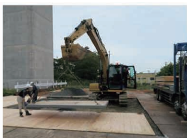
写真-21 吊上金物とワイヤーによる敷設作業とCLT敷板のズレ止め接合具
