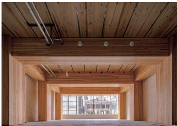
写真 1-2 スプリンクラー設備等による壁、天井の木質化
