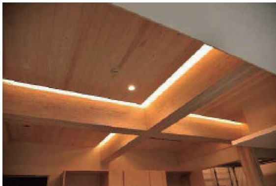
写真 1-1 天井は木質準不燃材料（塗装系）、壁は製材品
