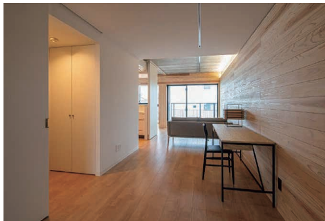
写真 1-6 防火設備等により 100㎡以下区画することによる壁の木質化
