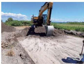
(a) 盛土撤去状況
