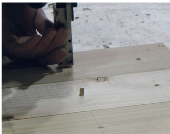
写真-3 木釘による機械的接合の様子
