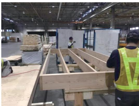
写真1 床パネルの作製
