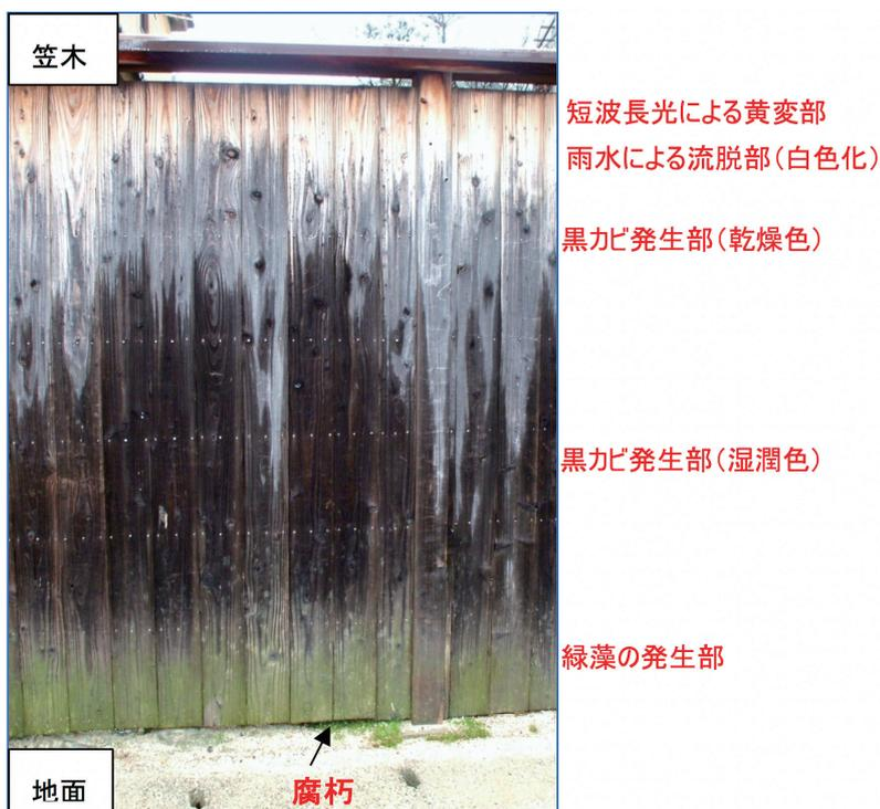
板塀の汚染と腐朽（スギ無垢材）
