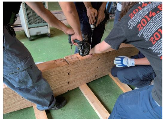
写真2 接合部への長ビス打ち込み
